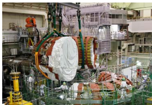
図2. 真空容器の吊り出し(H24年度)
