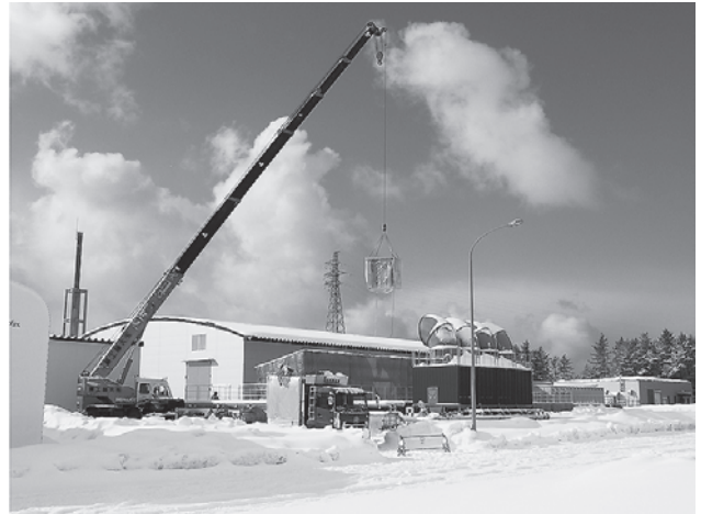
図4 IFMIF/EVEDA 開発試験棟の二次冷却水設備（冷却塔）の配管作業（左）、電気設備（屋外受配電盤）の搬入作業（右）。
