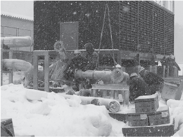
図4 IFMIF/EVEDA 開発試験棟の二次冷却水設備（冷却塔）の配管作業（左）、電気設備（屋外受配電盤）の搬入作業（右）。
