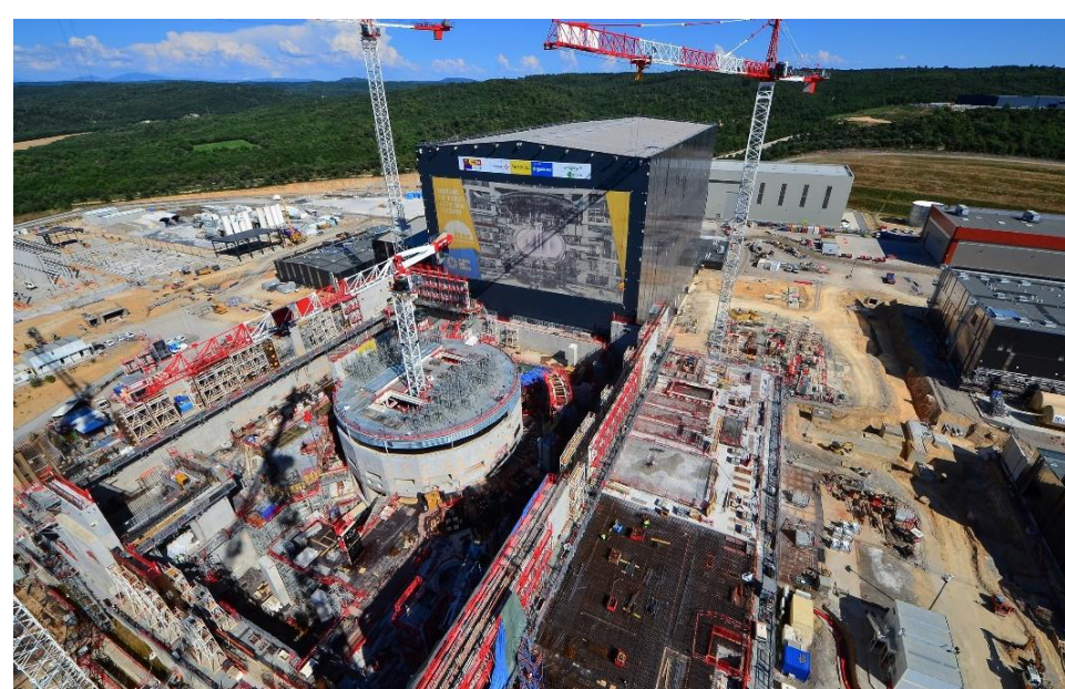
トカマク建屋 (2018.7月撮影)
