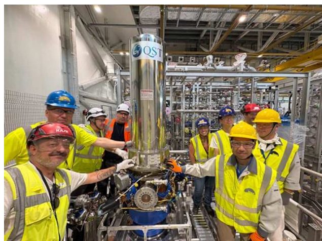
図4 ジャイロトロン1号機据付け完了時の写真。
