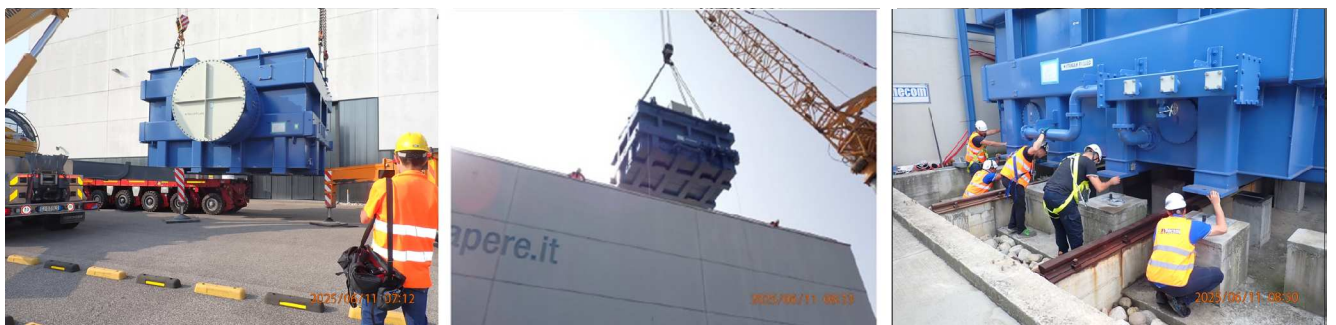
図5 NBTFサイトに搬入された1 MV絶縁変圧器の据付作業。
