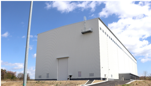
図1 竣工した先進加熱開発棟（外観）。
