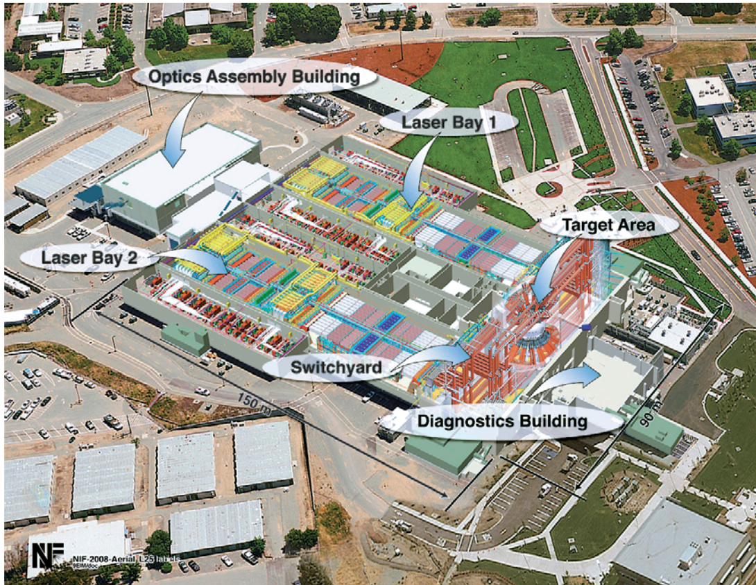
図1 NIFの鳥瞰写真。二つのレーザー室(Laser bay)、切り替え室(switchyard)、ターゲットチャンバー(target chamber area)、計測室(diagnostics building)等で構成されている。
