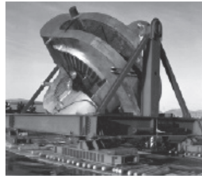
図4 MFTF-B 装置[Livermore]のインヤンコイルの搬入風景。6 m もの高さを有している。(出典: https://www.llnl.gov/str/January01/pdfs/01_01.3.pdf )
