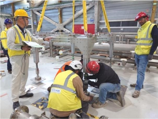
図3 ジャイロトロン架台の据え付け準備作業。
