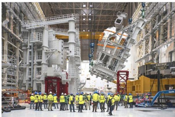
図 2 真空容器縦置き作業。
