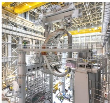
図 3 真空容器の SSAT への設置。
