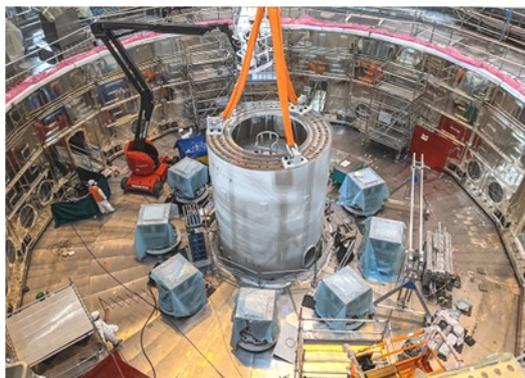
図5 トカマクピット内下部シリンダーの設置。
