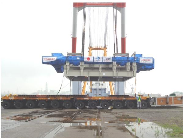
図2 TFコイル第3号機(TF10)海上起重機船での荷吊り作業(東芝エネルギーシステムズ(株)提供)。
