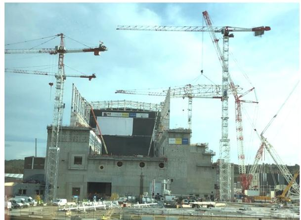
図5 ITERトカマク複合建家の屋根構造の設置。
