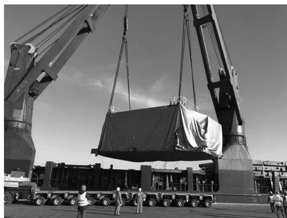
図 2 本輸送で最重量物となる外側構造物 BU の荷役。
