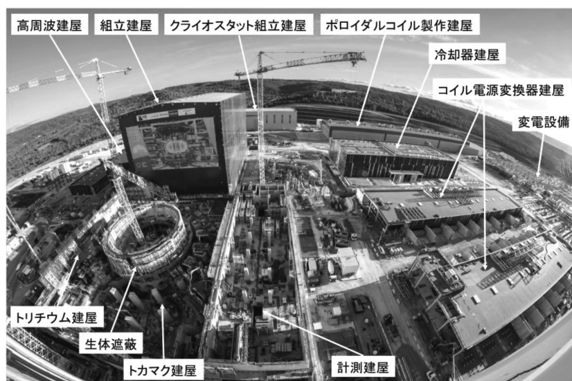
図7 ITERの建設状況 (2018年1月撮影 ITER機構提供) .
