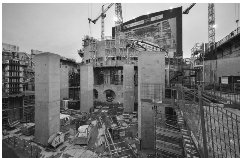
図8 ITERトカマク建屋の建設状況 (2018年2月撮影 ITER機構提供) . 直径30mの円筒の形を現した生体遮蔽. 丸い開口部は中性粒子ビーム入射、 四角の開口部は計測装置や加熱装置に使われる。
