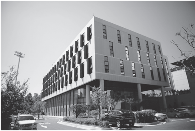
図3 韓国国内機関オフィスビル全景.
