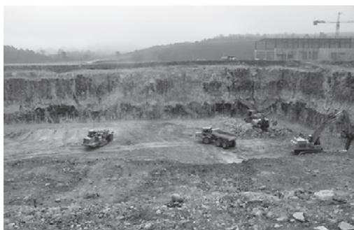
図 1 ITER トカマク複合建屋ピットの掘削工事がほぼ完了(2011年2月、ITER 機構提供)。
