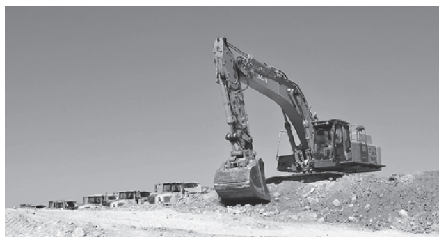
図2 2010年8月 トカマク複合建屋ピットの掘削工事開始（ITER 機構提供）。
