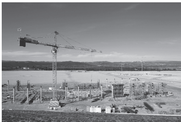
図5 2010年10月 ITER 建設サイトを望む。手前から PF 建屋、トカマク複合建屋ピット（中央右手）、アネックスビルディング（奥のクレーン2基）の各作業現場。
