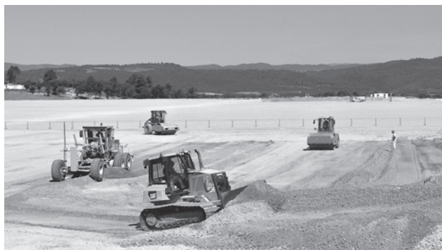
図3 2010年8月 ブルドーザーによる PF 建屋レベリング作業（ITER 機構提供）。
