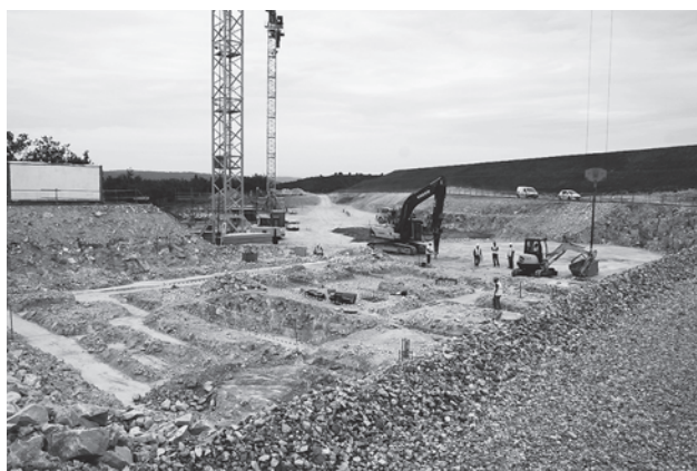
図4 2010年9月 アネックスビルディング基礎工事（ITER 機構提供）。
