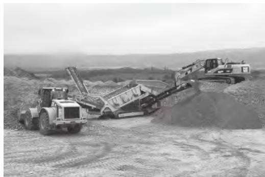
写真1 ITER建設サイトの整備作業が進展。
