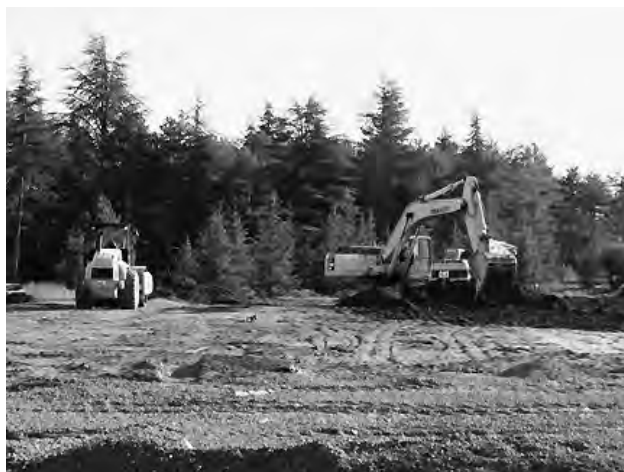
写真2 ITER 建設サイトの整備状況（ITER 機構提供）
