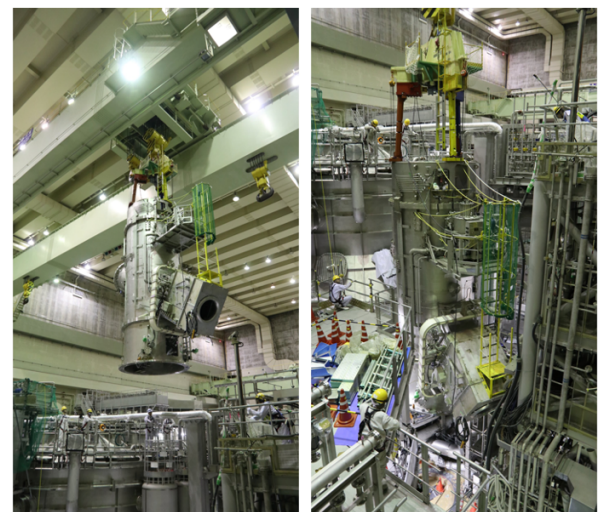
図5 本体室で据付場所に移動中の P-NBI タンク。
