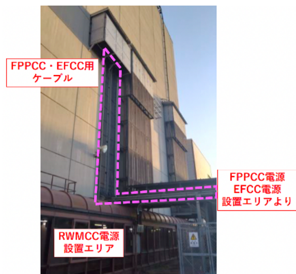
図 4 本体室外の真空容器内コイル用ケーブル。
