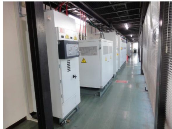
図 3 据付完了した RWMCC 電源。
