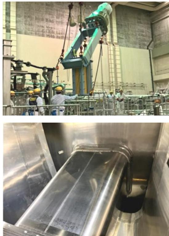
図3 (上) P04LOポート吊り込みの様子、(下) P04LOポート挿入後(真空容器管台部)。
