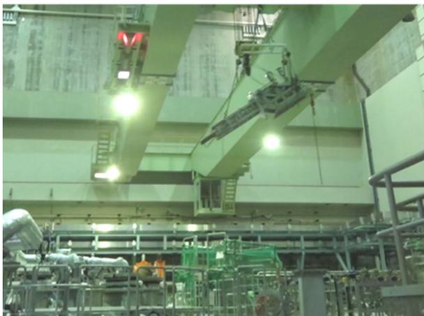
図3 導波管ランチャーをクレーンで運搬する様子。
