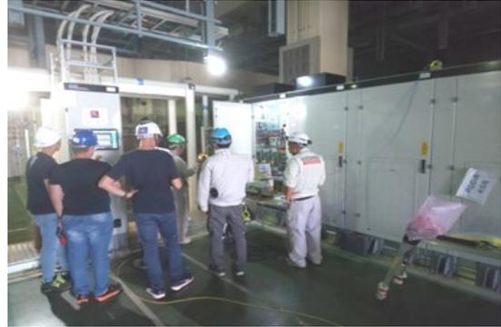
図4 (上) 据付されたEFCC電源, (下) 日欧担当者によるEFCC電源受入試験の様子.
