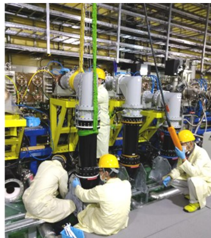
高周波伝送系接続作業の様子
