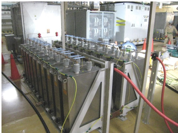
図2 据付が完了したリップル低減フィルタ.
