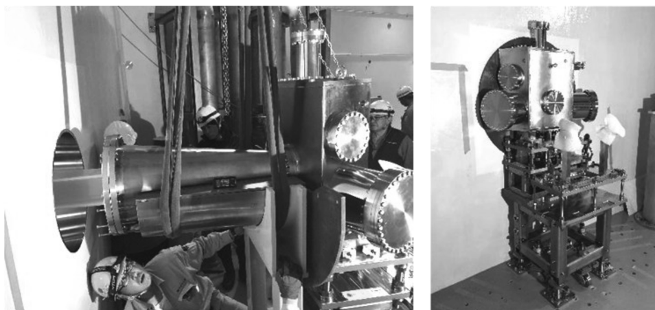
図3 コーン状ビームダクトと鉛シャッター容器の据付。
