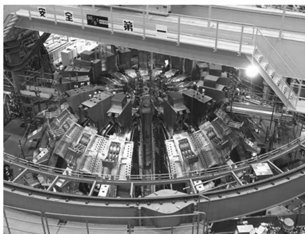
図4 17体目のTFコイルの設置完了.
