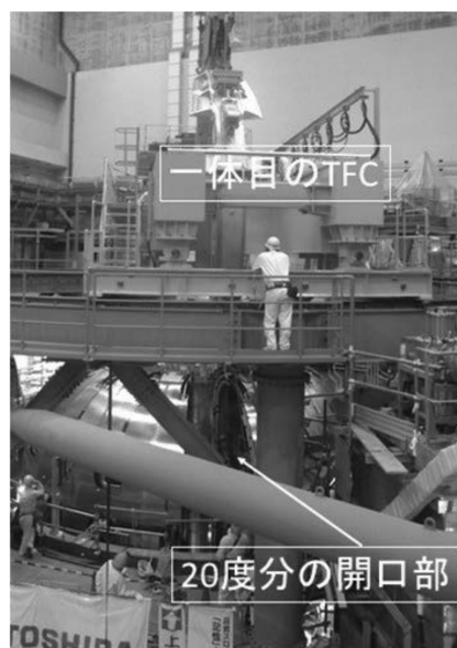
図 2 20 度分の空間から一体目の TF コイルを挿入する様子 (2016 年 10 月)。
