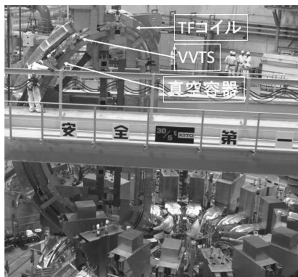
図5 18体目のTFコイル,VVTS及び真空容器を一体として,20度分の空間から挿入する様子.
