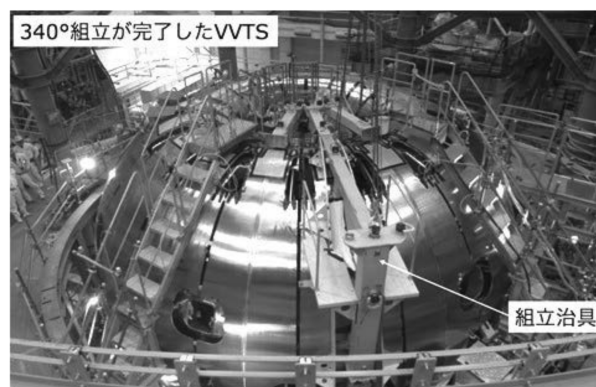
図4 組立てが完了したVVTS。
