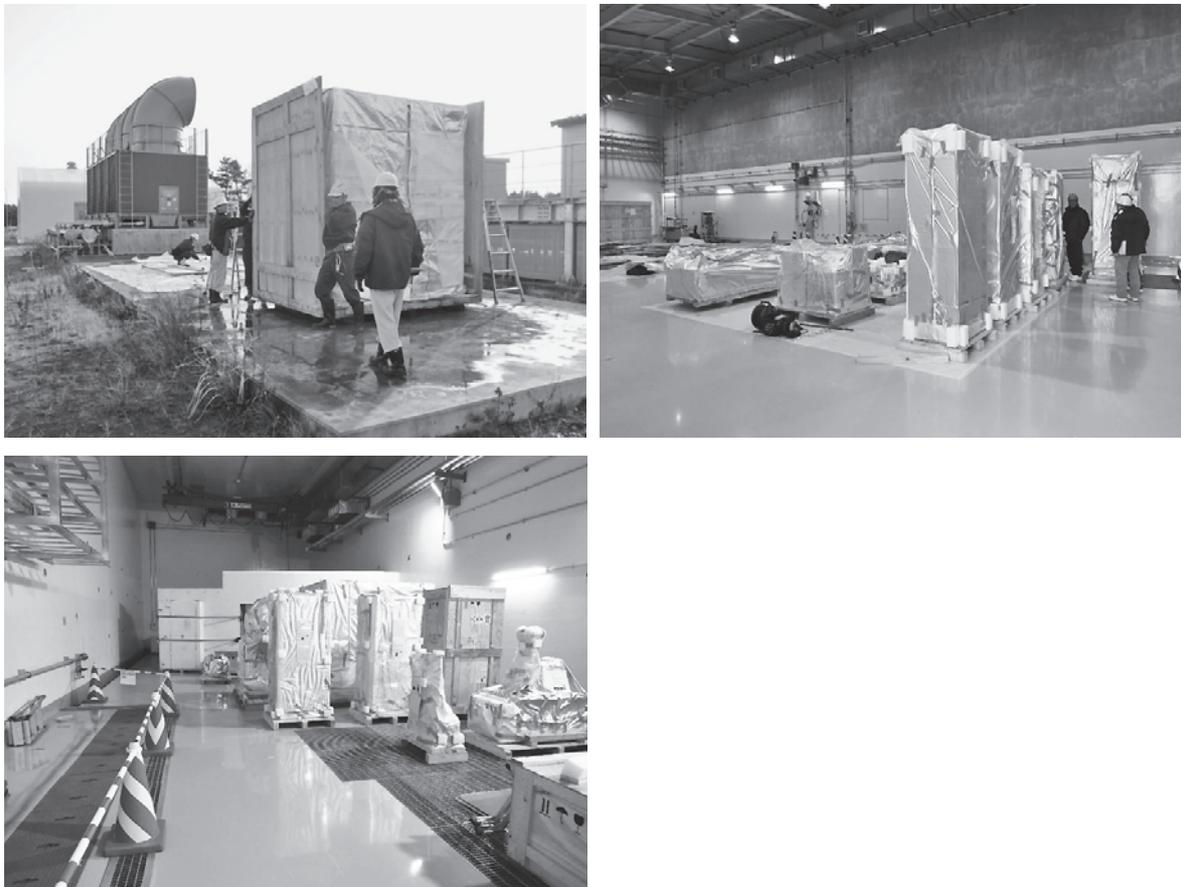
図3 開梱、搬送、内容物の確認の作業が行われているIFMIF/EVEDA原型加速器の入射器(左上から、屋外の配電盤の開梱作業、高周波源・電源室で開梱された制御パネル等、加速器室に移設された入射器本体部品等。11月27日、いずれも国際核融合エネルギー研究センターにて。)
