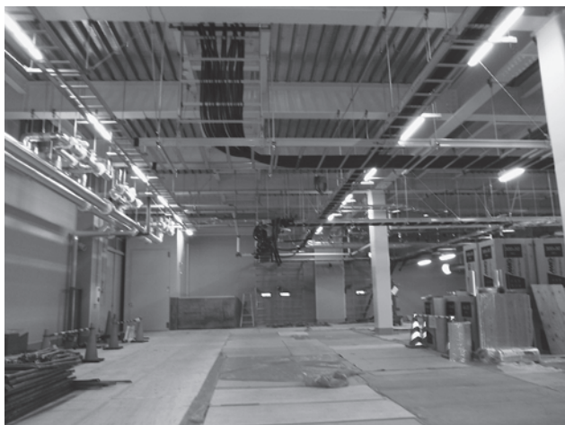
ケーブルの敷設が進む機械室
