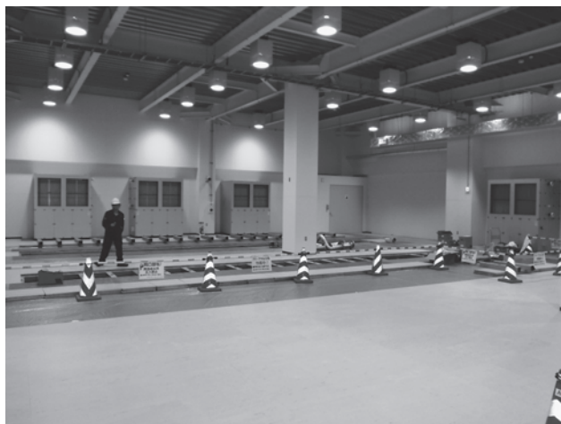
2階計算機室Ⅰで計算機用の冷却配管敷設作業中
