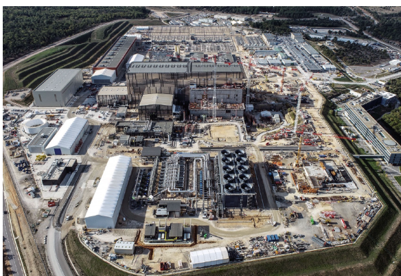
図1 建設が進む ITER サイト(2021年10月)
