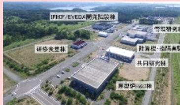
国際核融合エネルギー研究センター (青森県六ヶ所村) (量子科学技術研究開発機構)
