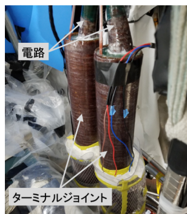
図2(a) EF1ターミナルジョイント(改修後)
