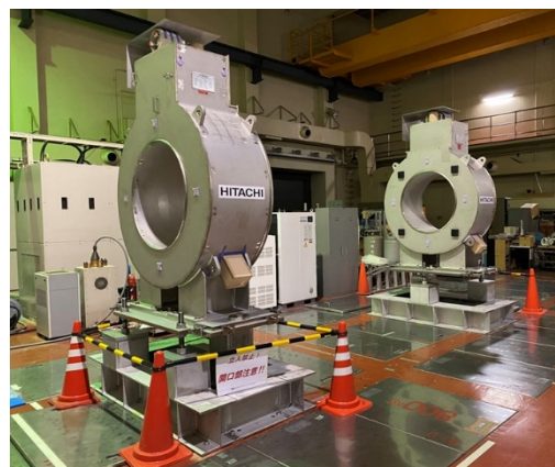
図2 高精度設置された超伝導コイル
