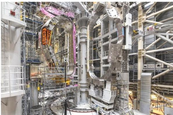
図4 サブセクター#7 TF09 (EU製) のSSAT設置。
