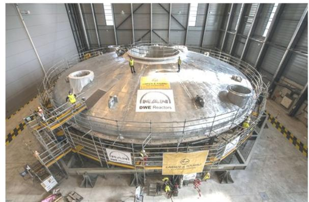
図5 クライオスタット上蓋：現地溶接完了。
