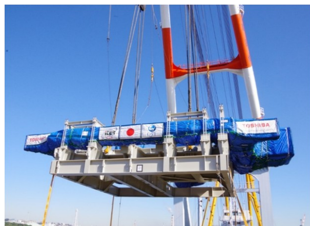
図2 吊り上げ中の TF コイル (TF16).
