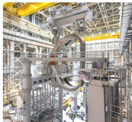
図 3 真空容器の SSAT への設置。
