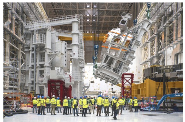
図 2 真空容器縦置き作業。
