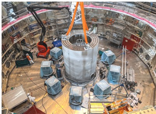
図5 トカマクピット内下部シリンダーの設置。
