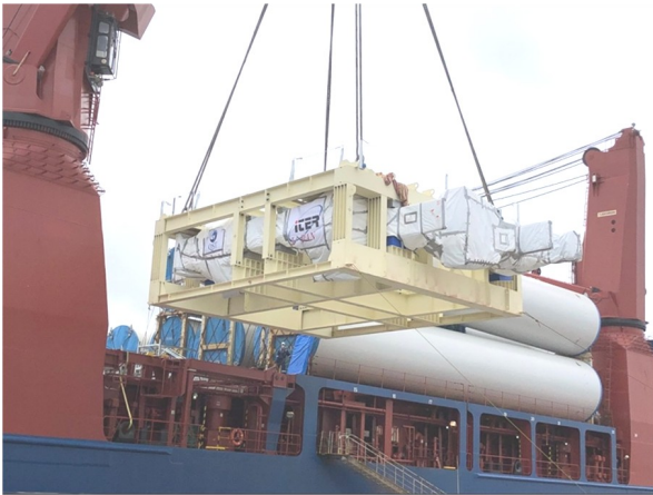
図2 TFコイル2号機, FOS港での荷揚げ作業.
