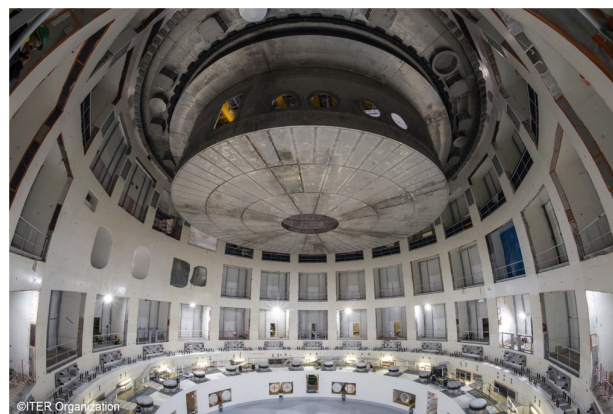
図5 クライオスタットのトカマクピットへの設置作業の様子. 上部に見えているのが, クライオスタットの底.
