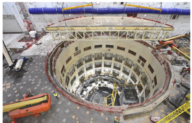
図5 蓋が取り外され、深さ30mのトカマクピット内部が見える。
