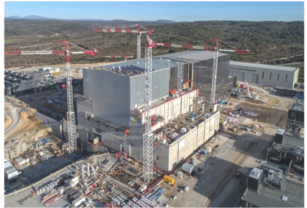
図4 ITER トカマク複合建家の屋根と壁の設置が完了。
