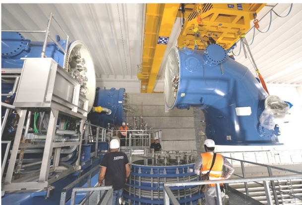
図 1 第 5 回試験の対象となる伝送ラインの据付の様子。
