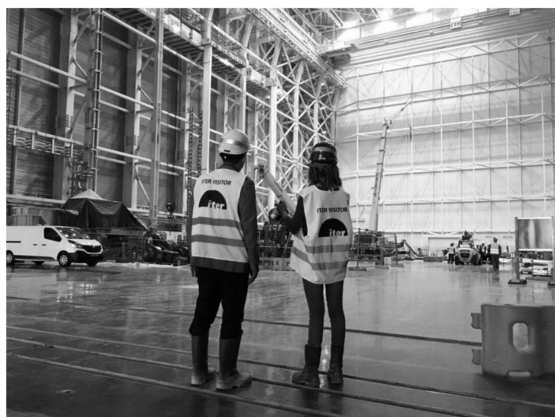
図7 建設中のトカマク組立建屋内部。
