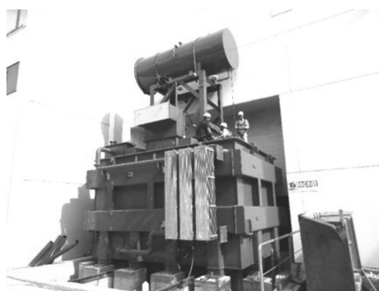
図3 1MV絶縁変圧器の組立作業。【左】屋内の複合ブッシング(高さ16 m)、【右】屋外の変圧器本体。
