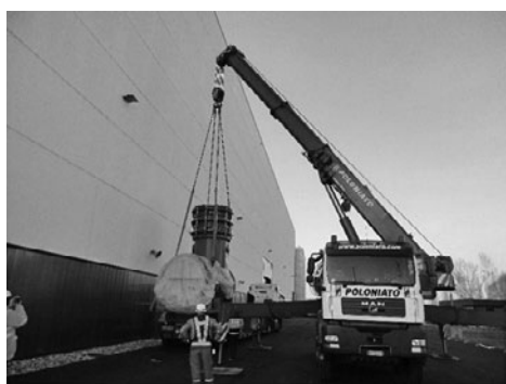
図12 トランスミッションラインの据付け.
