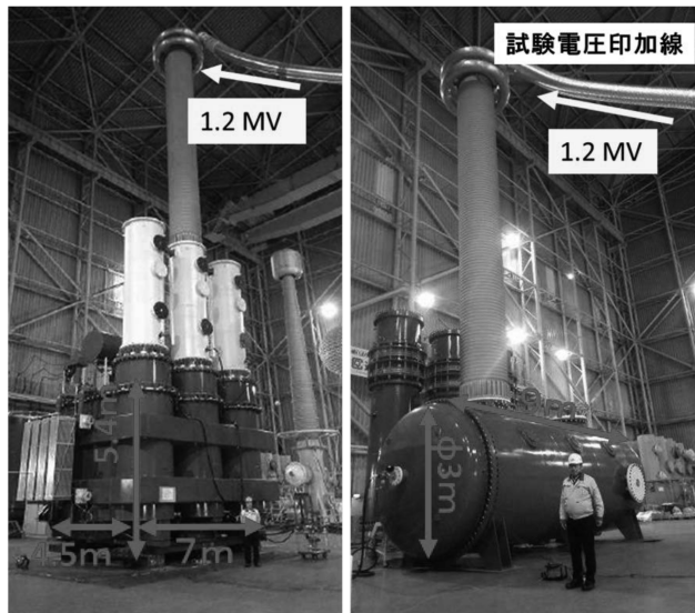
図2 直流 1 MV 超高電圧発生器：昇圧変圧器（左），及び整流器（右）。
