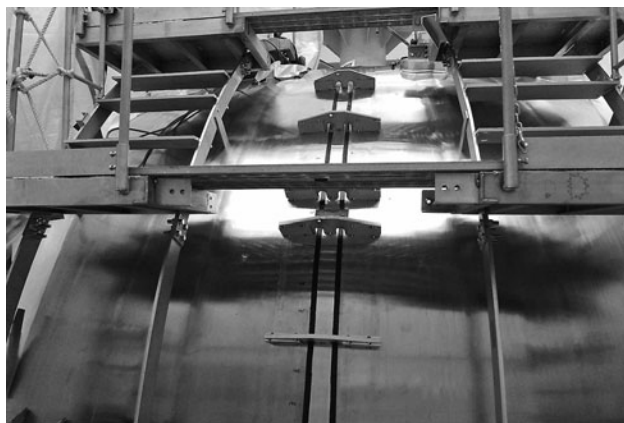
図5 接続溶接前のスプライスプレートを取り付けた真空容器。
