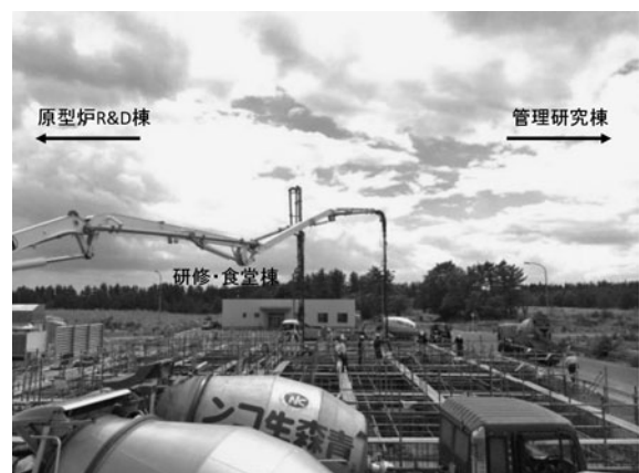
図3 共同研究棟の新築工事の現状(平成27年7月22日撮影)。
