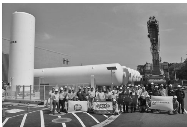
図5 据付けの完了したHe バッファータンクと550トンクレーン。
