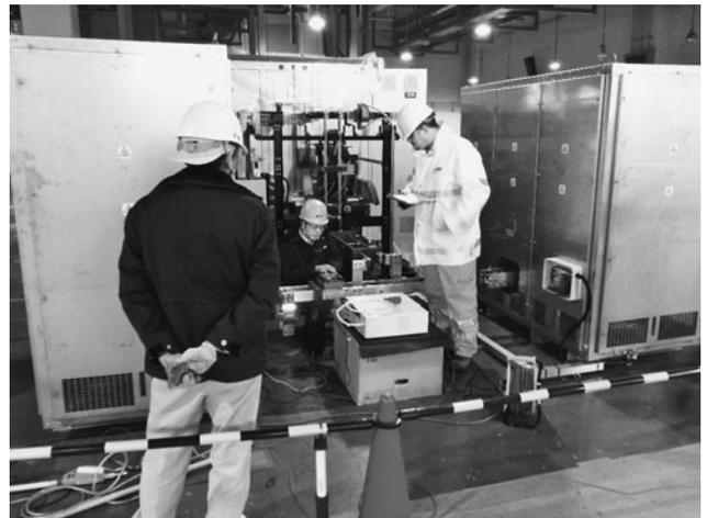
図3 据付けが完了したクエンチ保護回路と試験中の欧州作業員。
