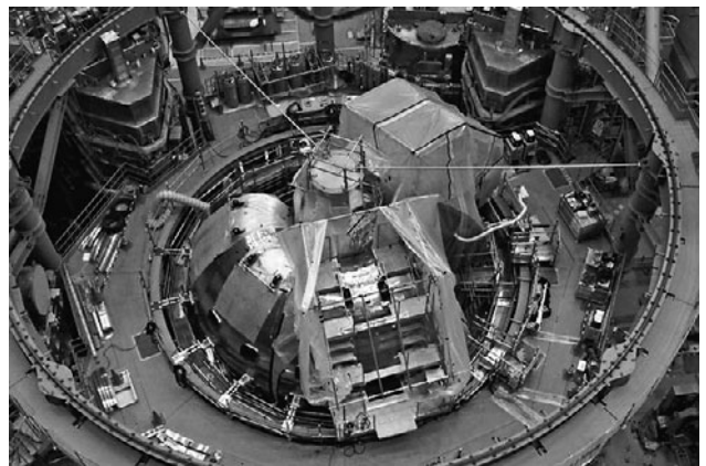
図3 組立中の6体の真空容器セクター（240度分）。
