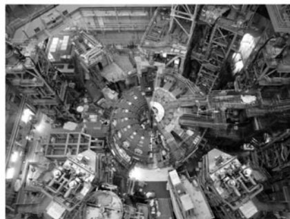
半分（9 個）のコイルを解体
