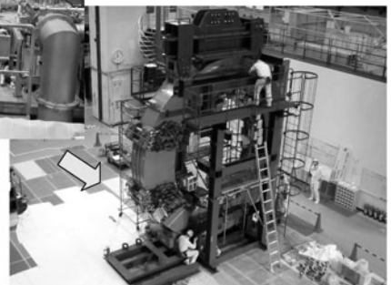
専用の受台に固定して搬出
