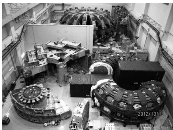
図9 解体品収納後の JT-60 機器収納棟。
