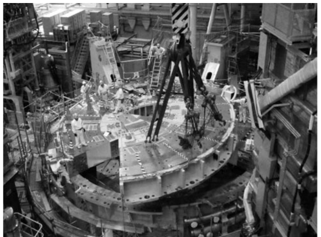
図19 下部架台類の解体(本体室)。
