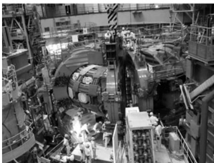
3 個目のコイルの解体
