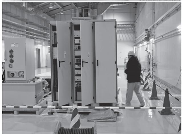
図2 入射器部品の据付作業(上:加速器室(LEBT),下:高周波源・電源室(制御系電源))。
