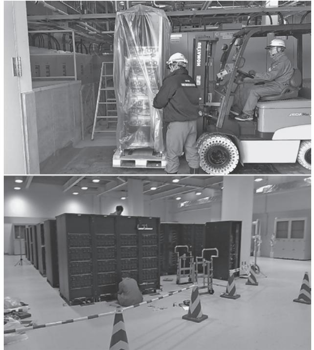
図3 「六ちゃん」の増強ラック搬入、設置作業（12月19日）、左：増強ラックの搬入、右：計算機室Iに設置された5台の増強ラック。
