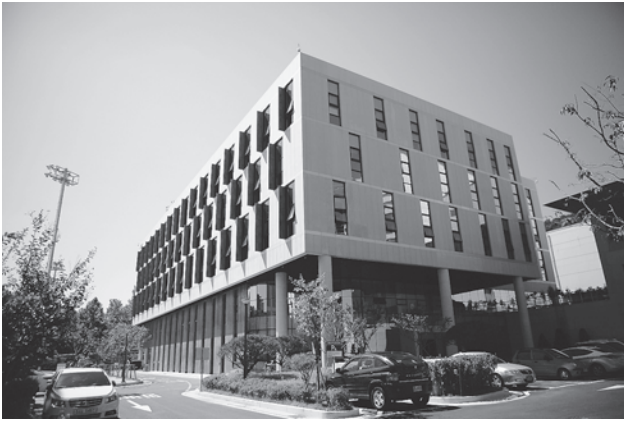
図3 韓国国内機関オフィスビル全景.
