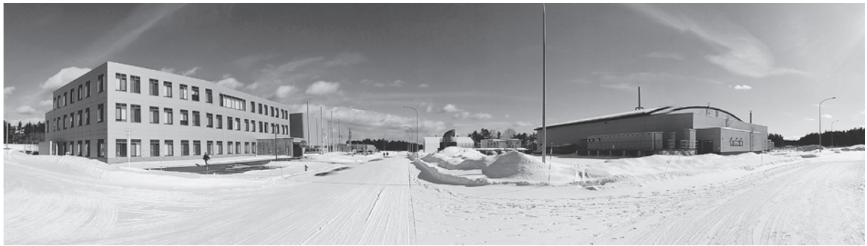
図4 すっかり雪景色になった国際核融合エネルギー研究センター（1月28日撮影）。
