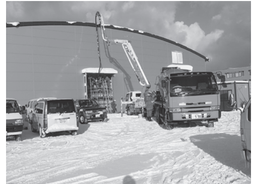
図3 IFMIF/EVEDA 開発試験棟の加速器室の改造作業（上：加速器室のビームダンプ周りの追加遮へい設置作業，下：加速器室最後部開口部の閉止作業）。
