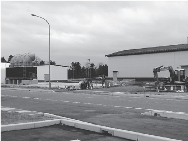
図3 IFMIF/EVEDA 開発試験棟の付帯設備の工事 (左から屋外基礎上のクーリングタワー、(奥) 冷凍機建屋、電源設備の工事)
