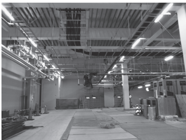
ケーブルの敷設が進む機械室
