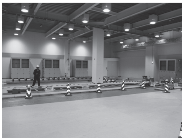
2階計算機室 I で計算機用の冷却配管敷設作業中
