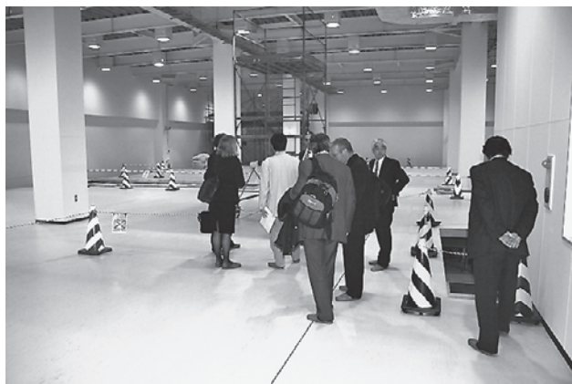
図2 電源設備、冷水供給設備等の整備が始まった計算機・遠隔実験棟（5月16日フランス Bull 社等の実地調査）
